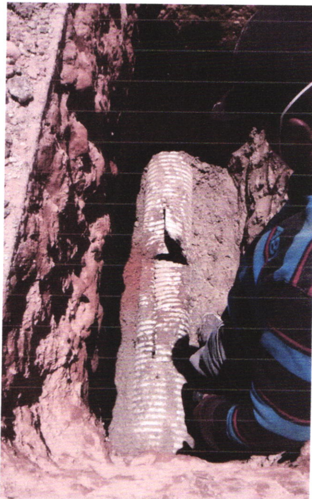
REPARACIÓN DE RED PRINCIPAL DE AGUA POTABLE.
