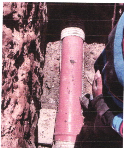
REPARACIÓN DE RED PRINCIPAL DE AGUA POTABLE.
